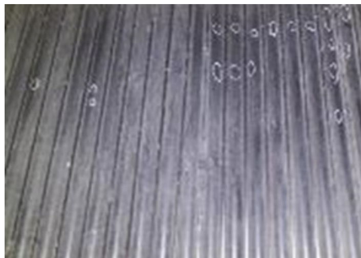
火炉壁管の外観(火炉内から見る)
